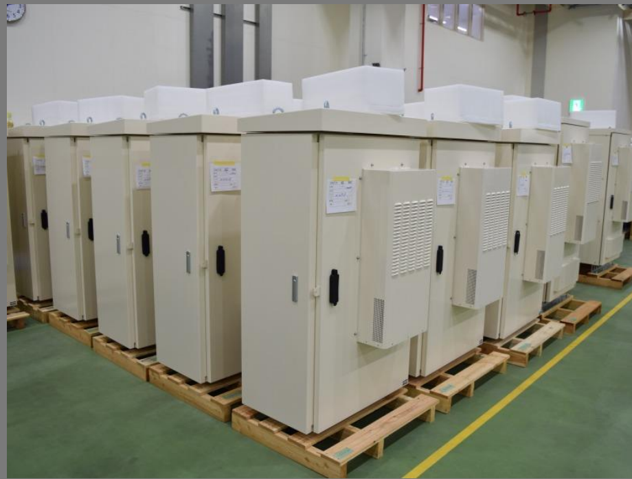
電源・蓄電池
