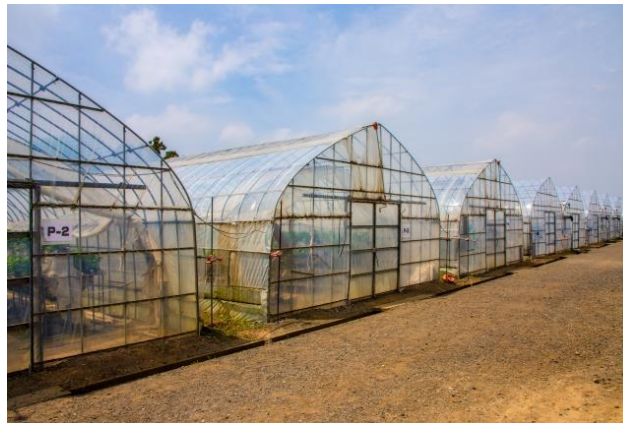
経年の塩害による錆の発生
