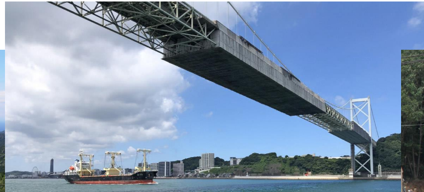
インフラ: 排ガスや塩害 防蝕・防塩害・防汚
